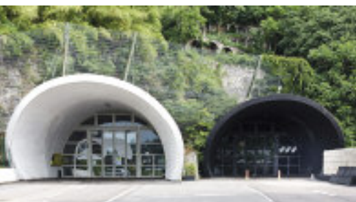
L'ingresso delle due gallerie.
